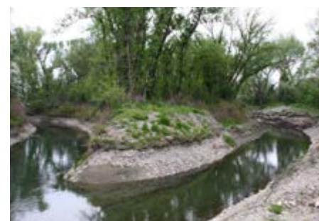
Exemple de travaux d'effacement de marges alluviales.
