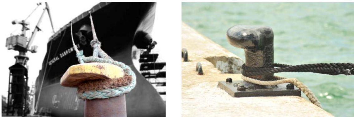
Figure 3 : Le bollard permet l'amarrage des bateaux aux quais. Il s'oppose à des forces latérales élevées en étant fixé sur une faible profondeur dans le béton !
